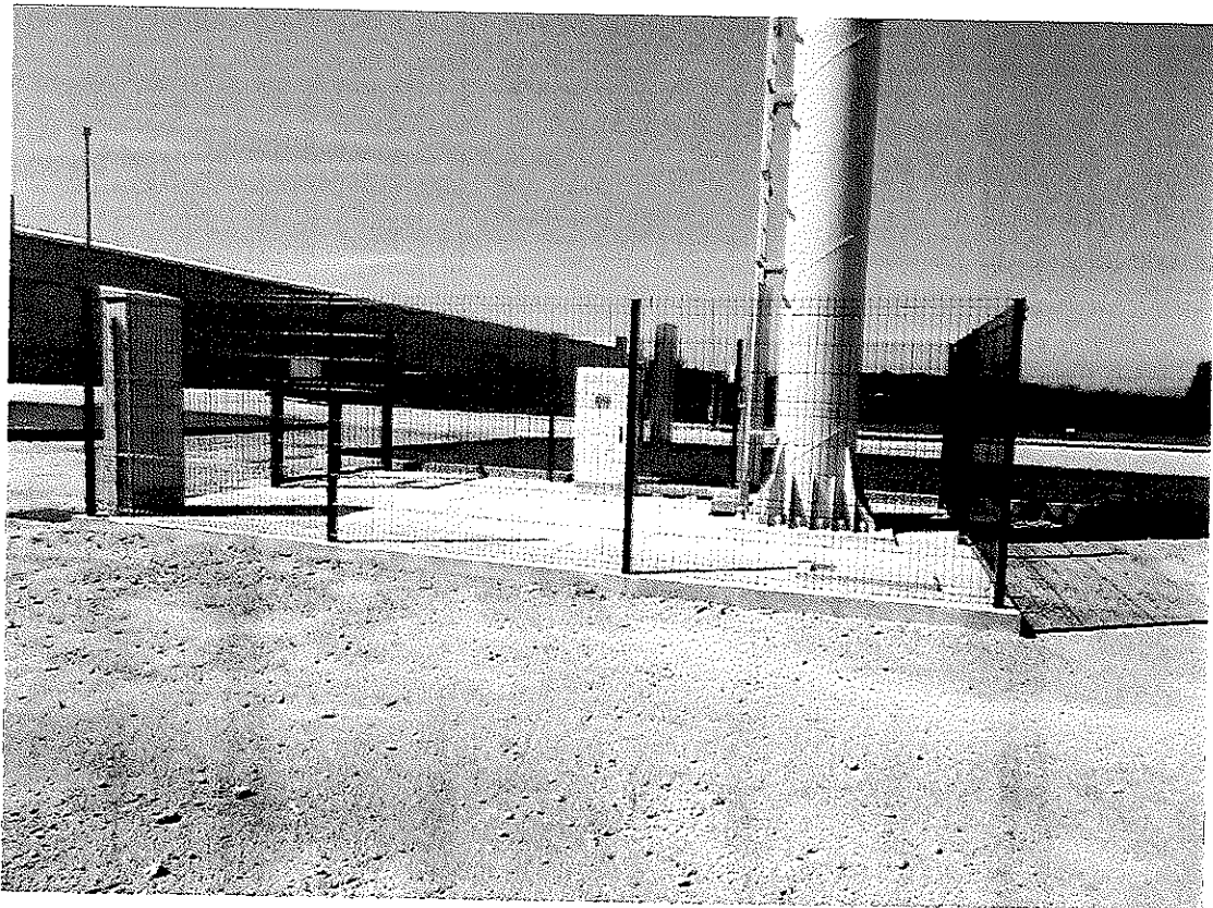
Fotografia com o tipo de infraestrutura a instalar
