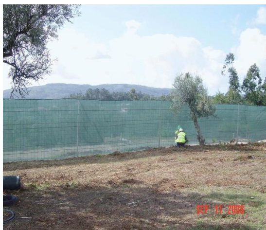
Fig. 1 – Execução de vedação do estaleiro
