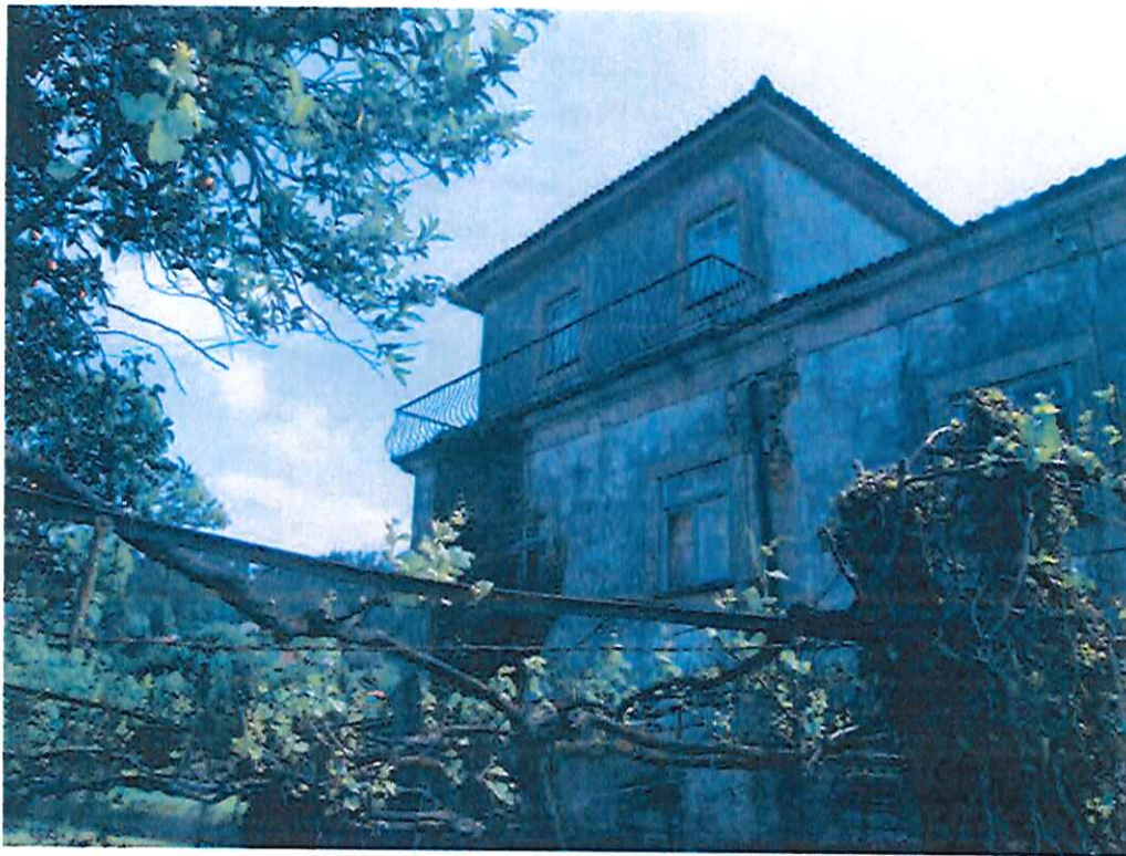
Vista parcial do alçado lateral esquerdo
