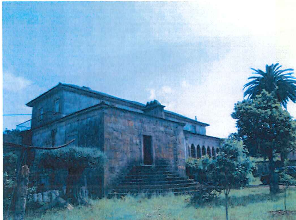
Vista geral do alçadoprincipal e lateral esquerdo
