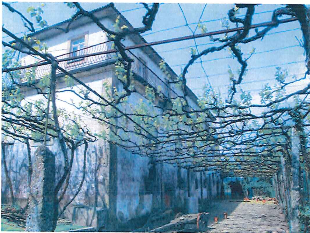
Vista geral do alçado posterior e parcial do lateral direito
