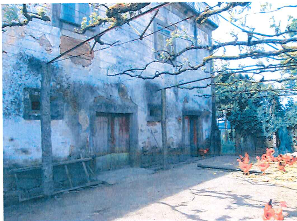
Vista parcial do piso inferior do alçado posterior
