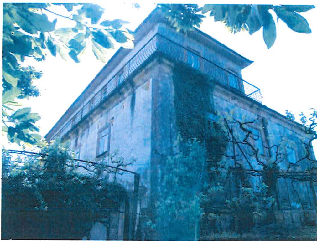
Vista geral do alçado lateral esquerdo com o posterior
